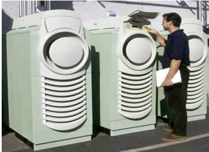
203. ábra. Kisteljesítményű gázturbinák (24 kW) párhuzamos üzemmódban.
