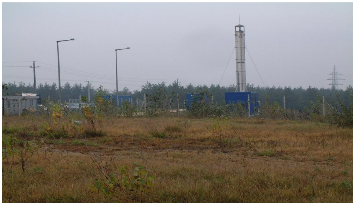
15. ábra. Hulladéklerakó-gáz égető-berendezés
