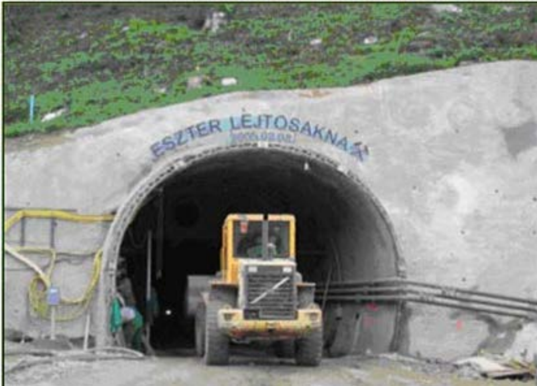
117. ábra. Az Üveghután épülő tároló bejárata
