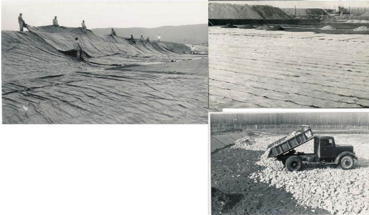
87. ábra. Perkolációs prizmák szigetelésének és drenázsának készítése (MECSEK-ÖKÓ Zrt, 1967)
