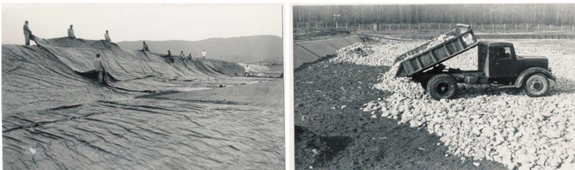
206. ábra: Perkolációs medencék kialakítása
