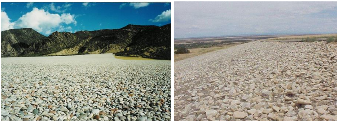
221. ábra: Rézsű és a teljes felszín letakarása osztályozott kavicsos (Monticello, Rifle, USA) vagy darabos kötőréteggel
