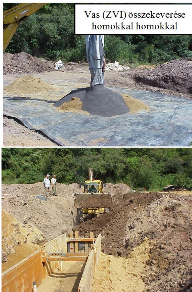
256. ábra: Reaktív gát létesítése (MECSEKÉRC RT:)
