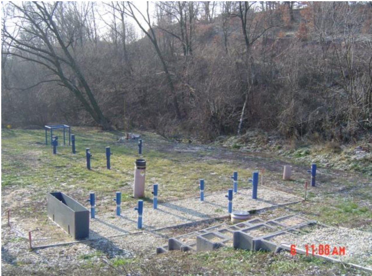
257. ábra: Reaktív gát monitoringja (MECSEK-ÖKO Zrt).
