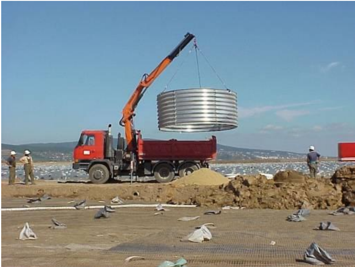
244. ábra: Nyelőkút létesítése a konszolidációs víz összegyűjtése céljából (MECSEK-ÖKO Zrt)
