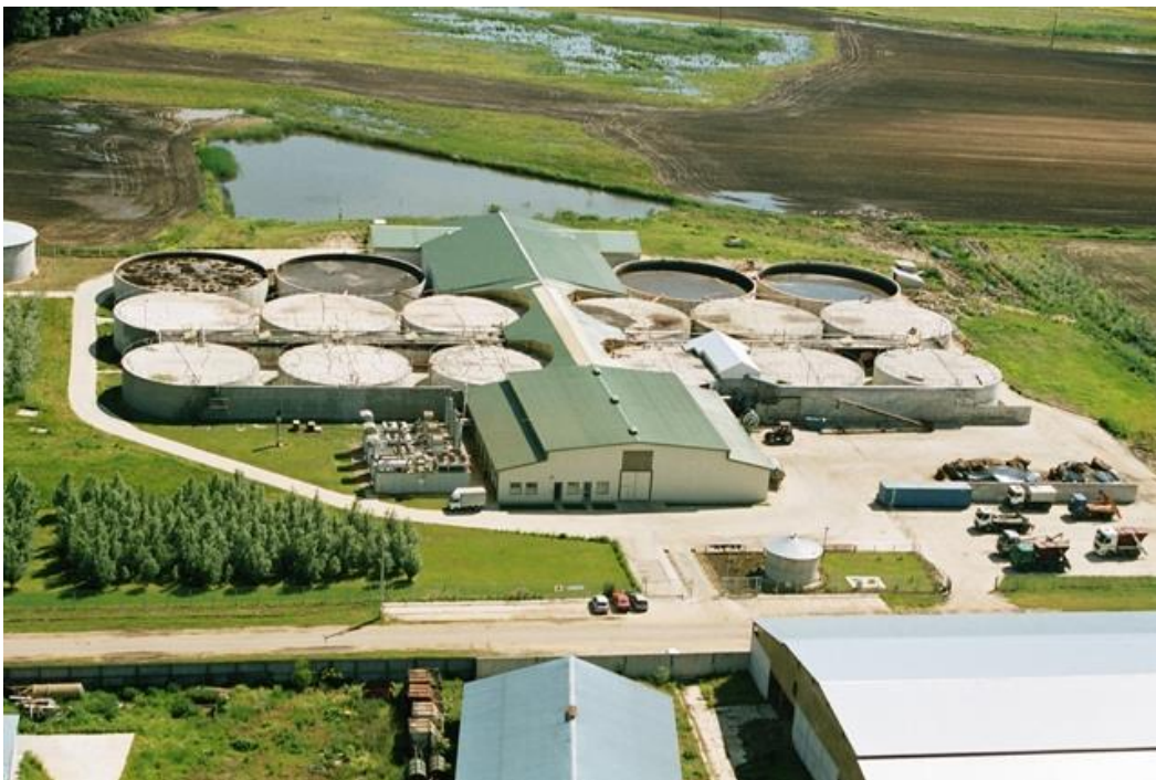
109. ábra: A nyírbátori biogáz üzem [4.]
