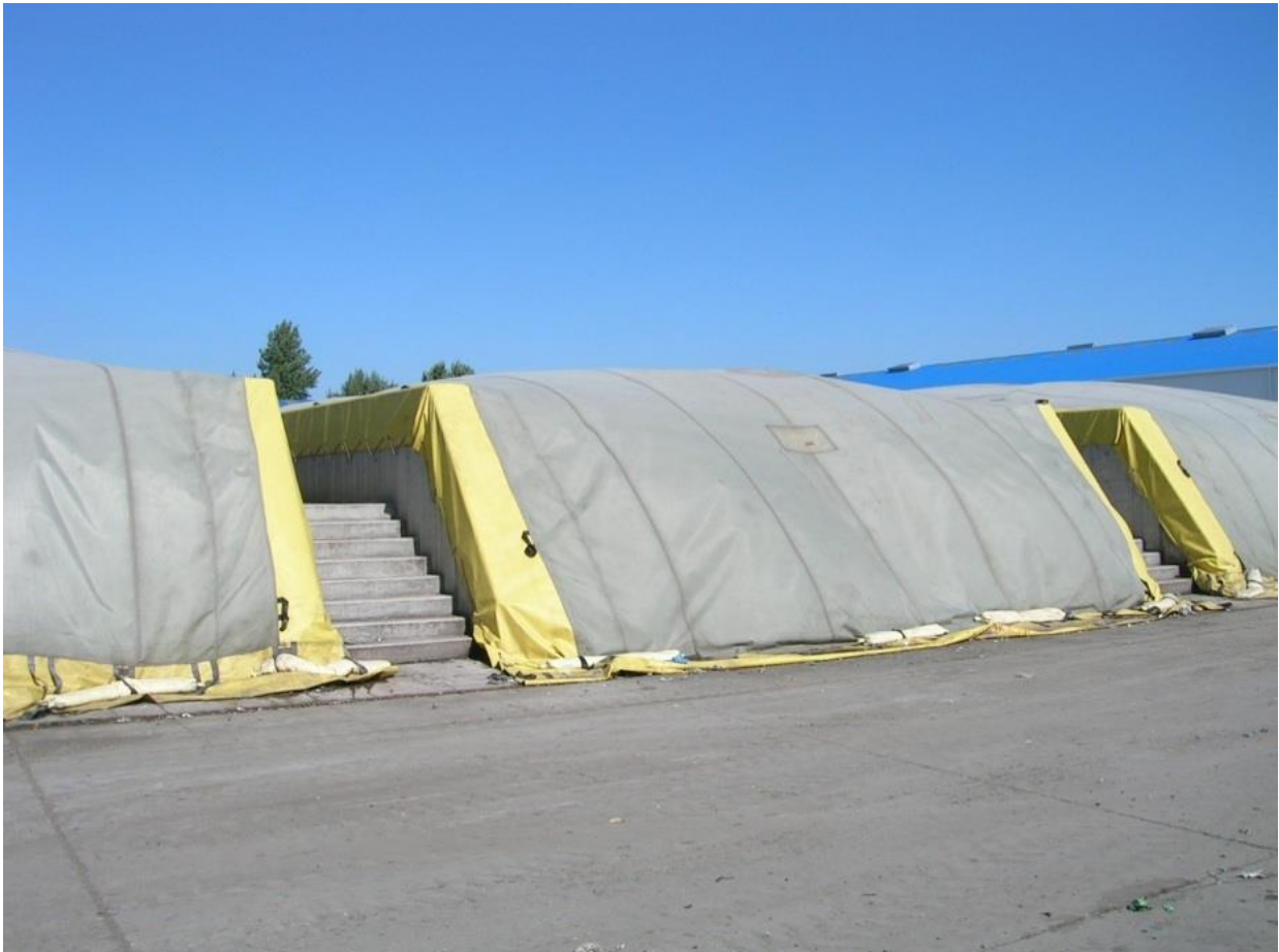
66. ábra: Szemipermeábilis fóliával takart hulladék (© Buruzs, 2010)
