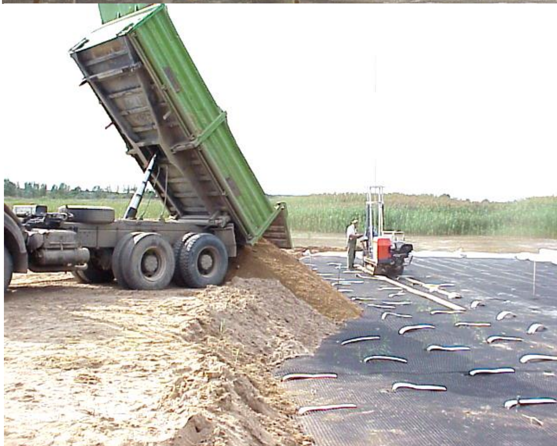
243. ábra: Zagyatározó iszapmagjának víztelenítése mély-drének elhelyezésével és fokozatos terheléssel (MECSEK-ÖKO Zrt)
