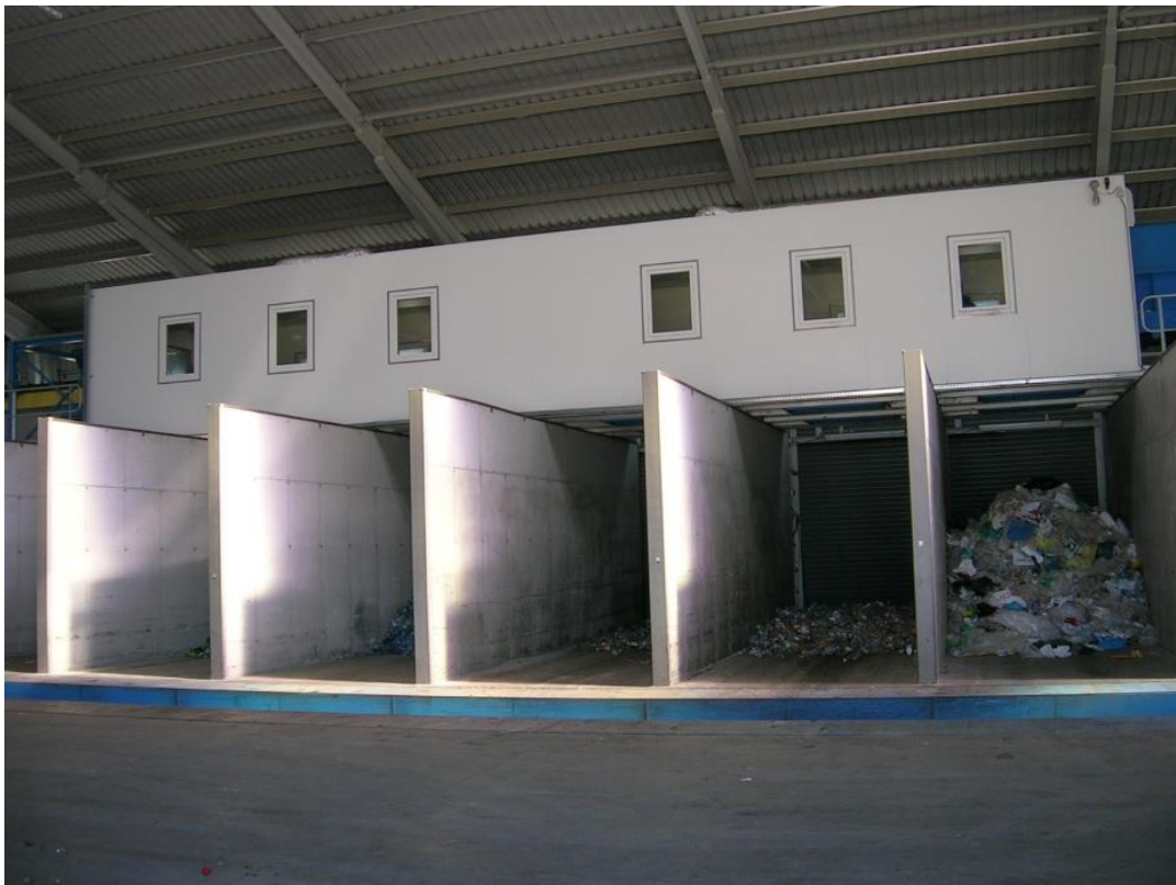
71. ábra: Válogatómű kézi szortírozó egysége (© Buruzs, 2010)
