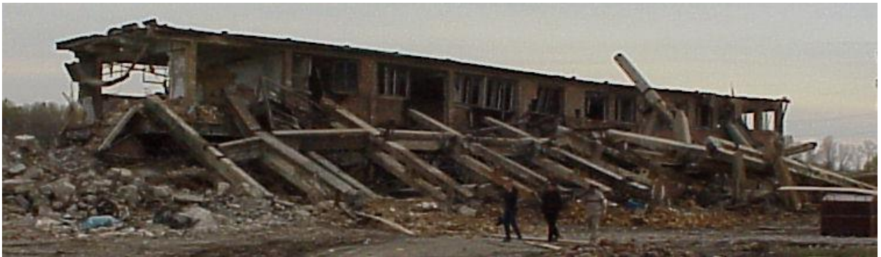
250. ábra: Az Ércdúsító Üzem törő-órló üzemrésze működő és lerobbantott állapotban (MECSEK-ÖKO Zrt)
