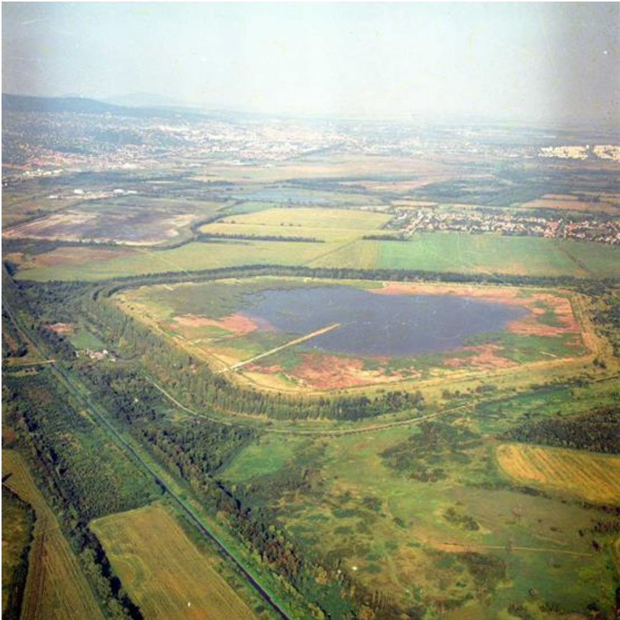
203. ábra: A meddő zagy formájában való elhelyezése a zagytéren (Magyarország, MECSEK-ÖKO Zrt I. zagyártározó. 1993., szabad víz a központi részen, homokos parti rész a gát-közeli részen, az iszap döntő része a víz alatti iszapmagban)
