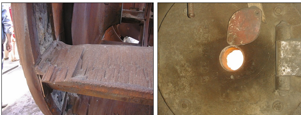
118. ábra: Szénórló malom kopása / Tűztér ellenőrző nyílása
