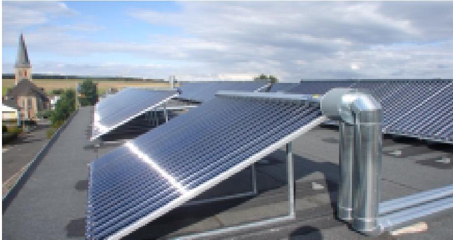
327. ábra: A tetőn elhelyezett kollektorok [5.7]
