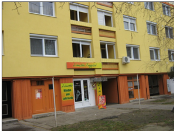
92. ábra: Szegedi panelházak külső fal felújítása és nyílászáró cseréje (2010)
