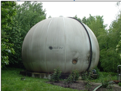
131. ábra: A hódmezővásárhelyi Szennyvíztisztító gáztározója
