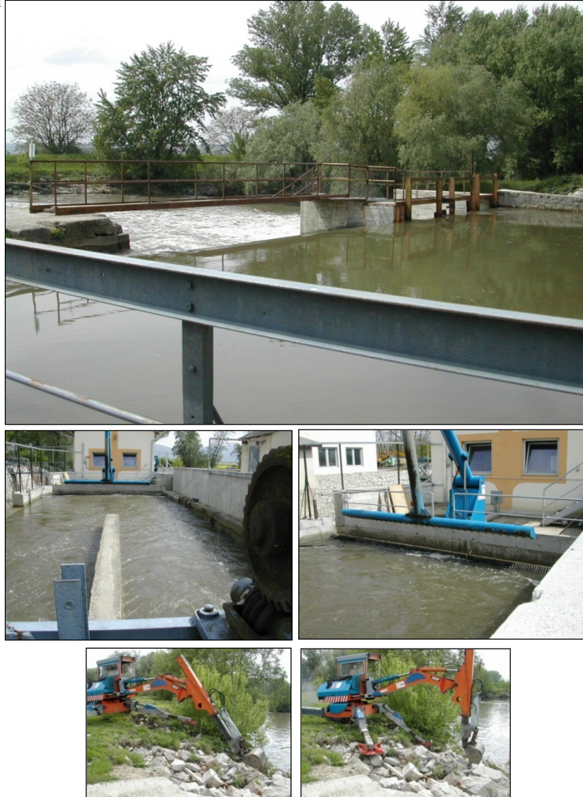
150. ábra: Mini vízerőmű a Nyitra folyón, partfal karbantartása
