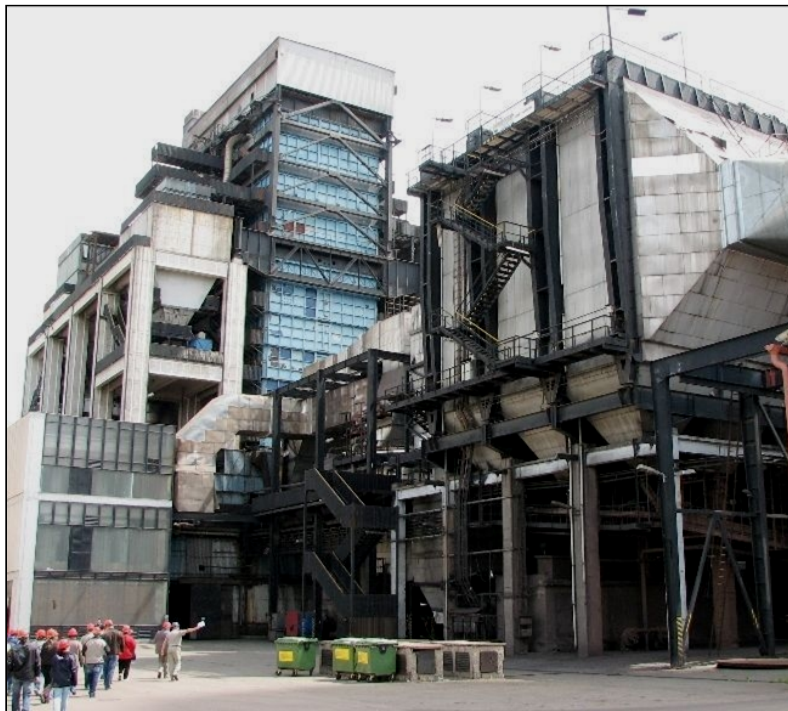
117. ábra: Erőművi blokk: kazán, szénórló malom
