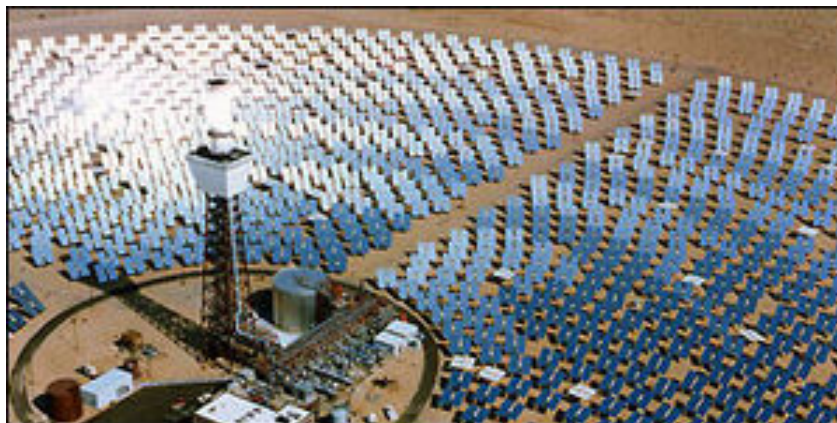
321. ábra: Torony típusú naphőerőmű [5.8]
