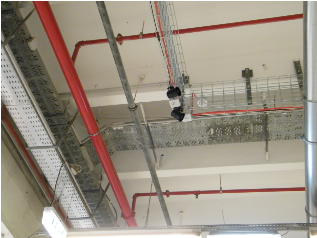
34. ábra Telepített tűzérzékelő és jelző berendezés (forrás: szerző)
