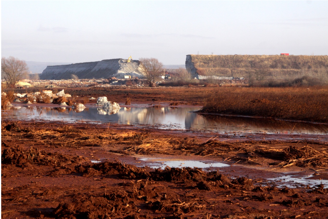
22. ábra Vörösiszap katasztrófa (2010. október 4.) A megsérült tároló távlati képe fotó: Nagy Lajos
