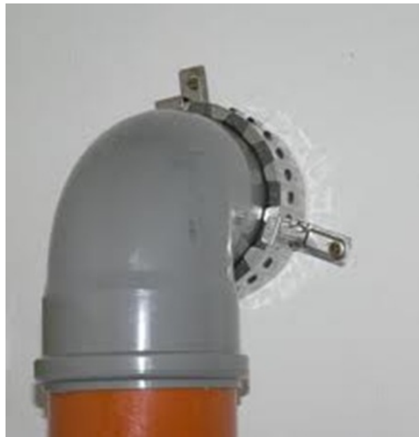
29. ábra Tűzgátló csőmandzsetta (forrás: szerző)
