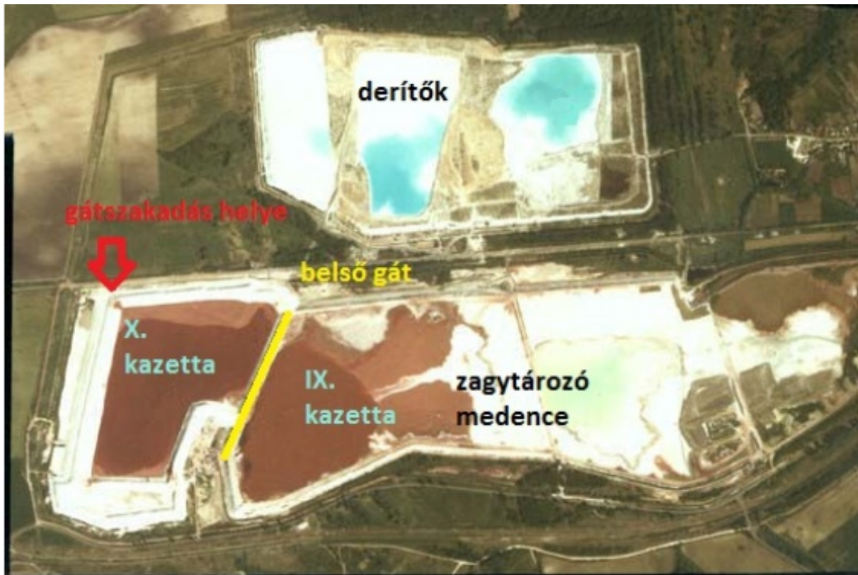
78. ábra Gátszakadás helyszíne – 1
