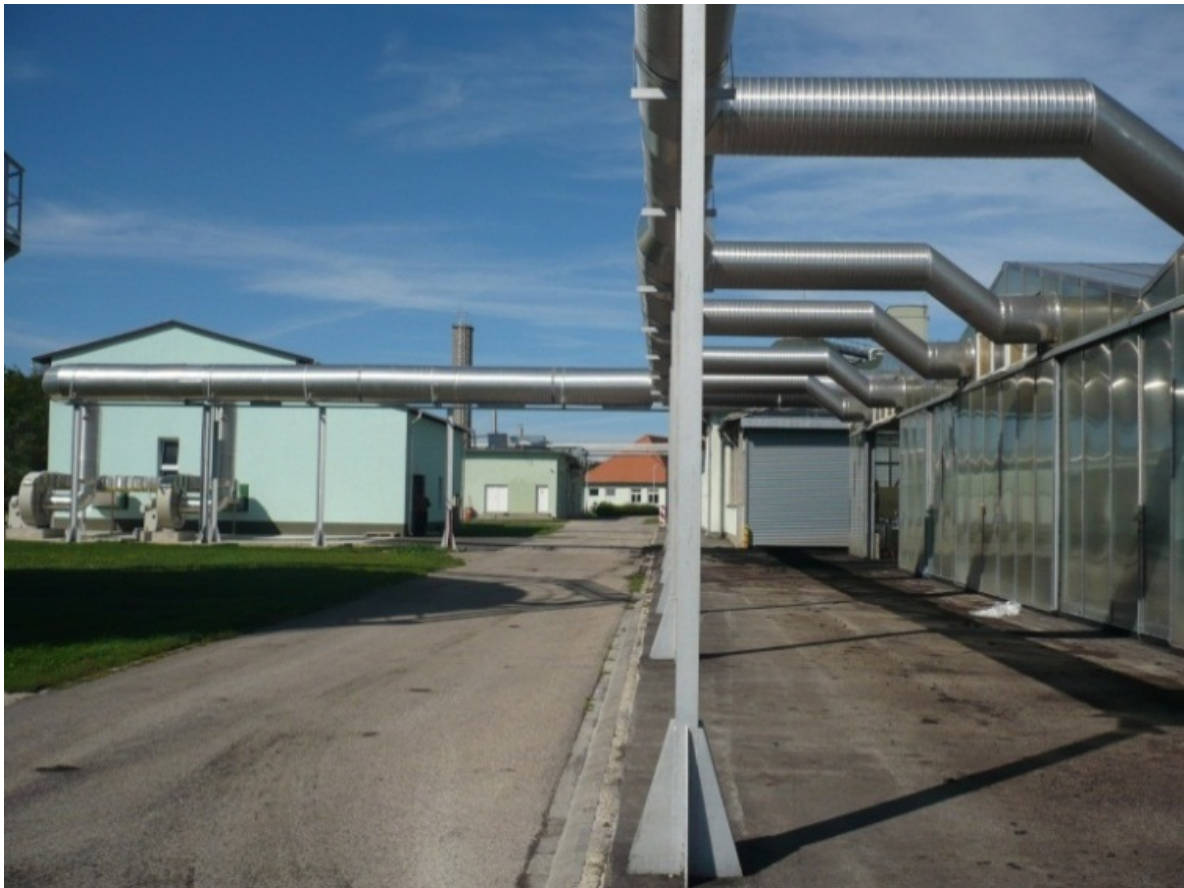
80. ábra A szárítósorok megszívása, gázvezetése, s a gáztisztító épülete Veszprémben
