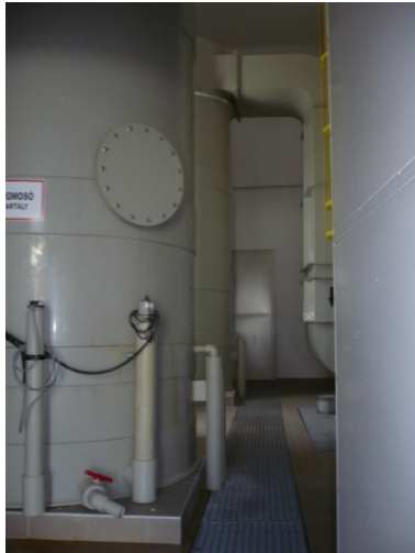
81. ábra A kénsavas mosótornyok a szárítógáz ammóniájának megkötésére, valamint a biológiai utótisztítás vegyszer előkészítő-, adagoló részlege
