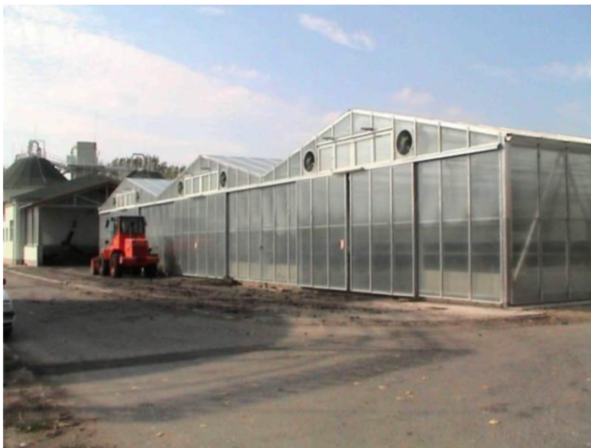
78. ábra Veszprémi szennyvíztisztító 3 szoláris iszapszárító csarnoka előlnézetben a szárítógáz elszívásának és tisztításának kiépítése előtt
