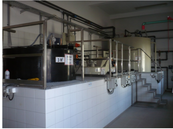
81. ábra A kénsavas mosótornyok a szárítógáz ammóniájának megkötésére, valamint a biológiai utótisztítás vegyszer előkészítő-, adagoló részlege
