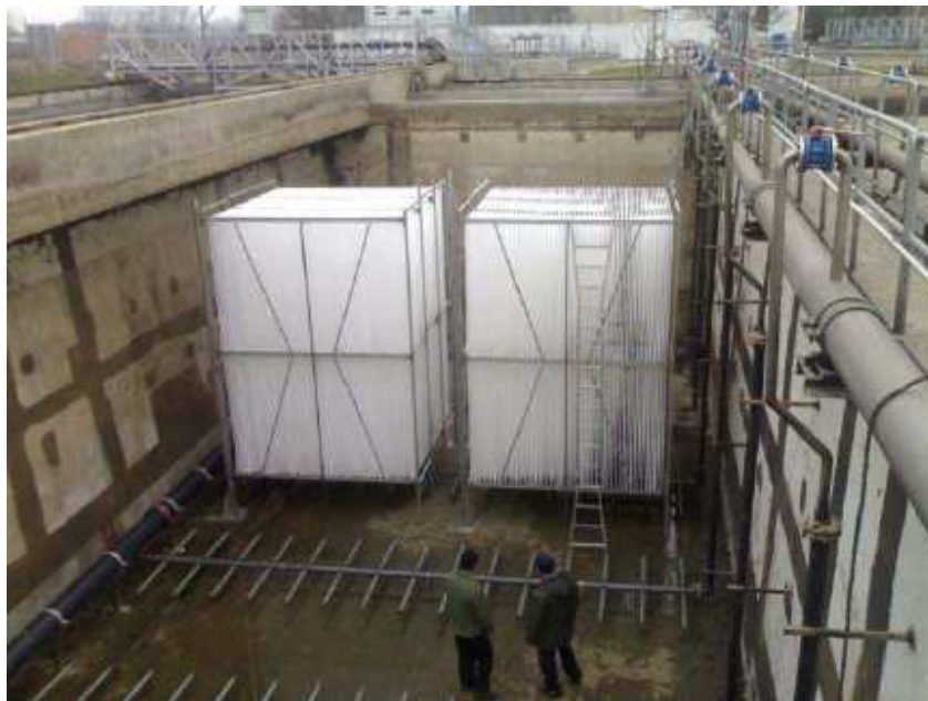
33. ábra: Rögzített hordozós elárasztott hibrid szennyvíztisztító.
