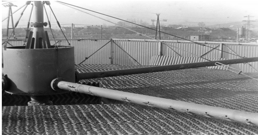
14. ábra: Műanyagtöltetes csepegtetőtest és felületének a szabályozott nedvesítése.
