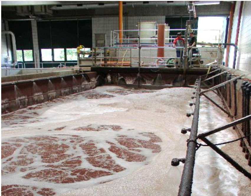
46. ábra: A Straas-i iszapvíz nitrogénmentesítő medence a granulálódó iszapjával.
