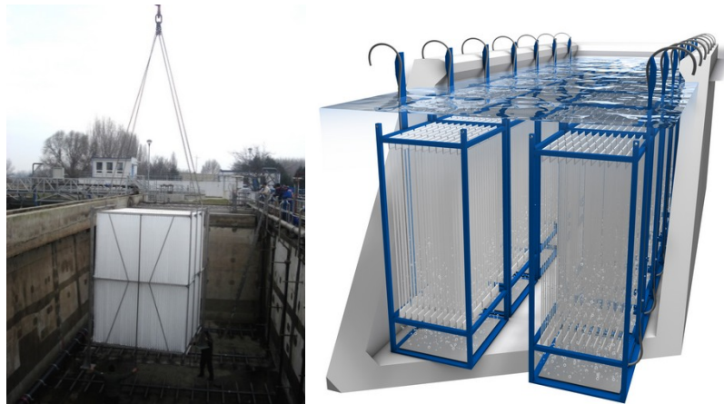
34. ábra: Függönyszerű töltet beépítése az eleveniszapos medencébe.
