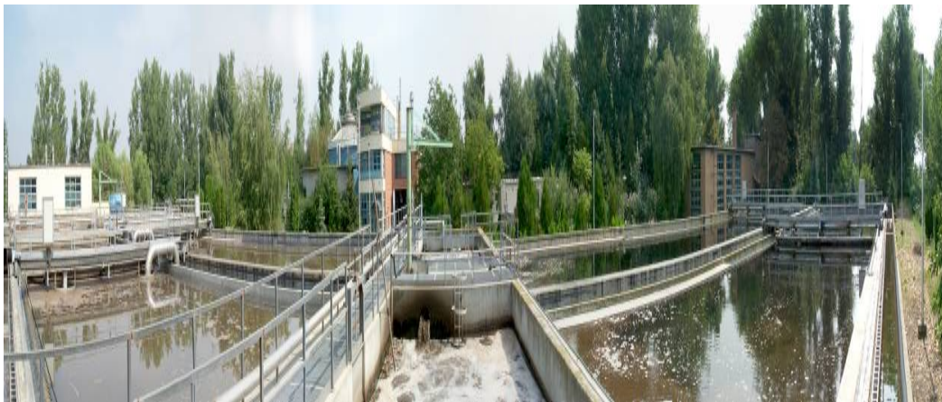
49. ábra: A hódmezővásárhelyi szennyvíztisztító két iszapkörös kialakítása
