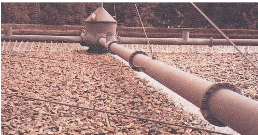
12. ábra A múlt század fordulóján sikeresnek bizonyult zúzott kő töltetes csepegtetőtestek.
