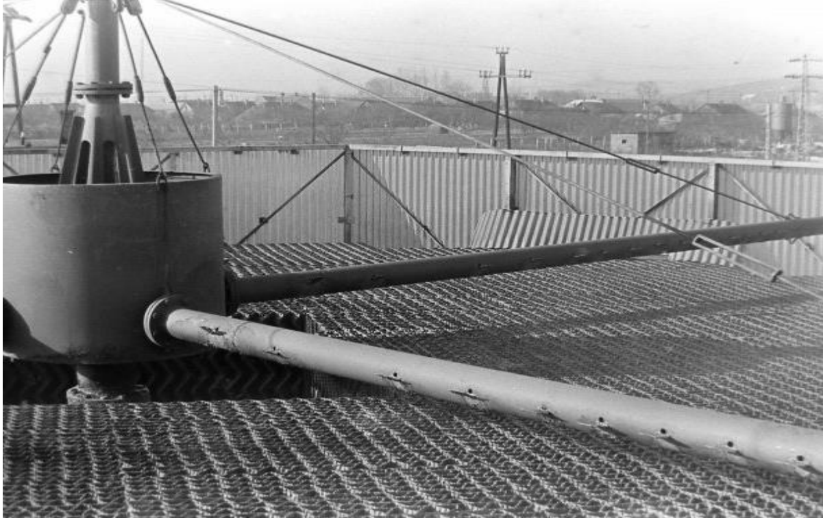
13. ábra Műanyagöltetetes csepegtetőtest ülepített szennyvíz szerves anyagának eltávolítására, vagy utónitrifikáció biztosítására.
